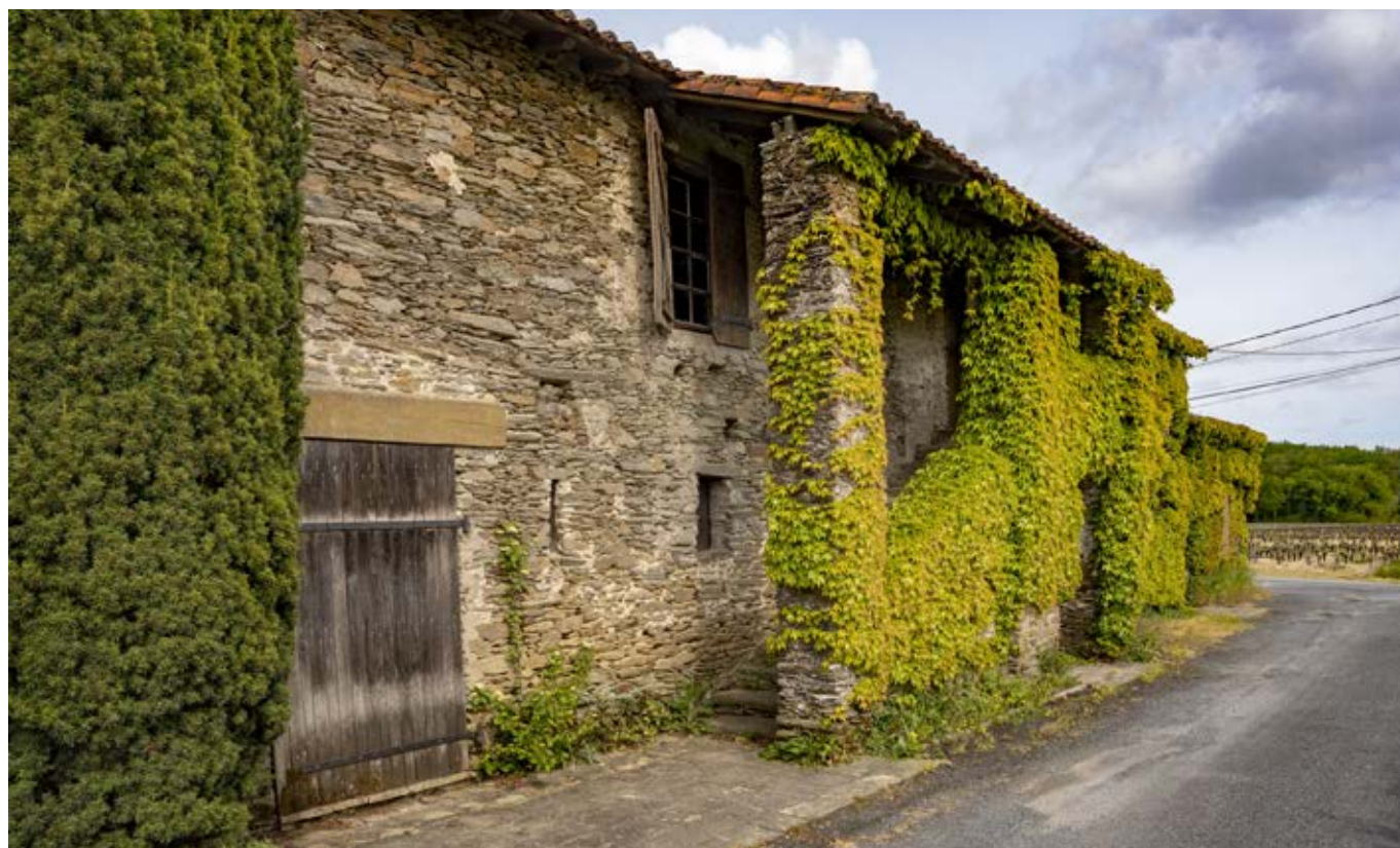
Escalier menant à l'étage d'habitation, à l'ouest du chai du négoce Piou. © Région Pays de la Loire – Inventaire Général : PB Fourny, 2021
