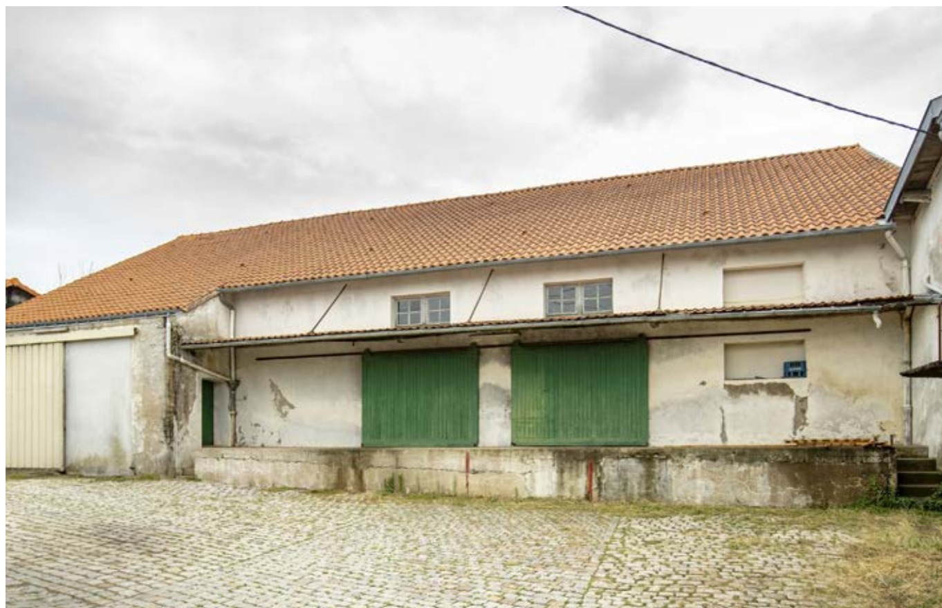
Façade et quai du magasin d'E. Cormerais. © Région Pays de la Loire - Inventaire Général : PB Fourny, 2022
