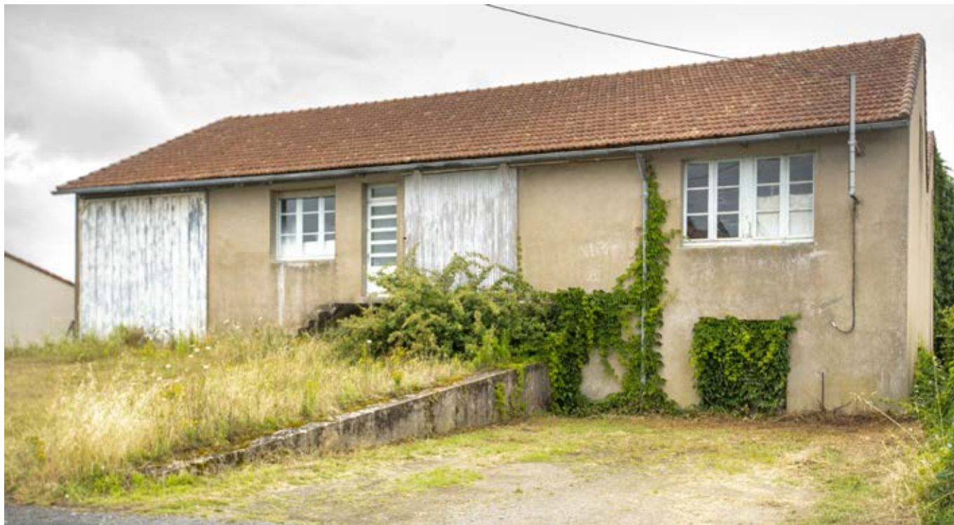
Bâtiment du négoce Marchand, avec son quai de chargement. © Région Pays de la Loire – Inventaire Général : PB Fourny, 2022
